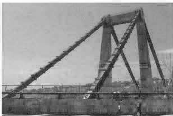
Figura 6: intervento di consolidamento degli stralli della pila 11
