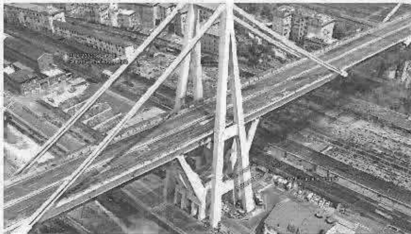
Figura 2: sistema bilanciato pila n.9 oggetto del crollo
