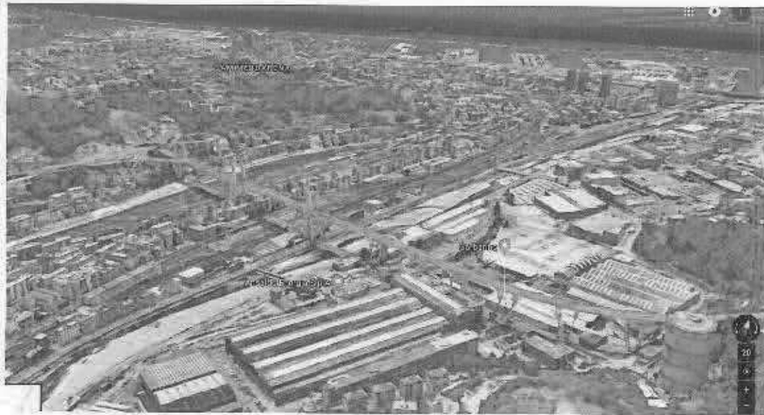
Figura 1: vista del viadotto da nord ovest
